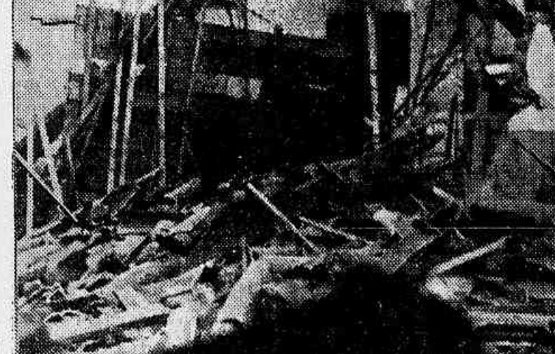
A casa n. 1, depois do desabamento
